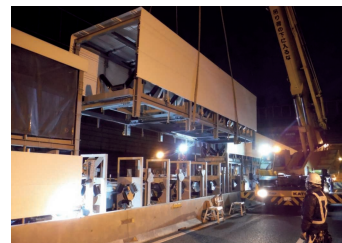
東京外環自動車道工事現場
