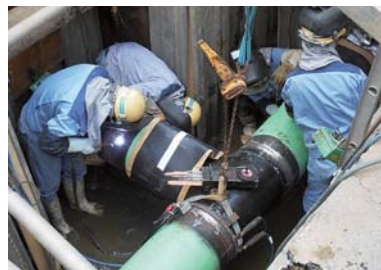
▲三重幹線の建設工事
