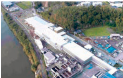
有明ポーンプラント拡張箇所
