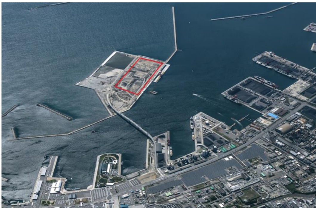
小名浜東地区石炭ターミナル整備運営予定地
