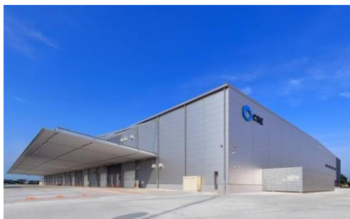
ロジスクエア羽生 2016 年 7 月竣工
