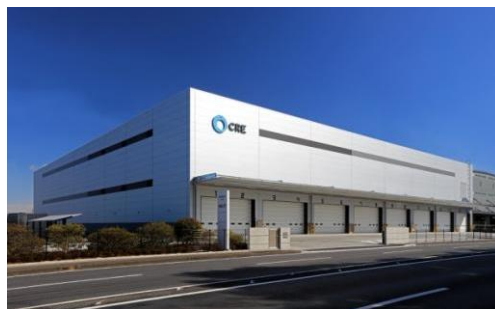
ロジスクエア久喜Ⅱ 2017 年 2 月竣工
