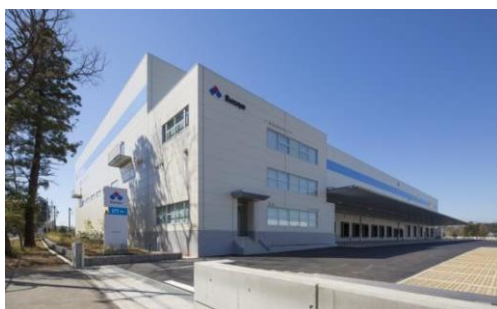
ロジスクエア日高 2015 年 3 月竣工
