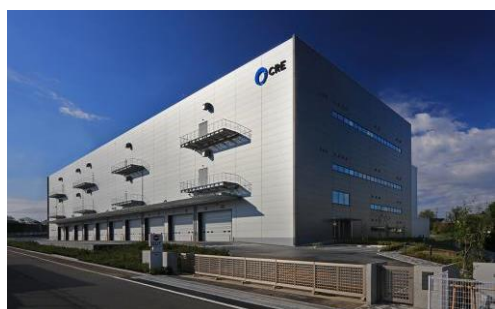
ロジスクエア新座 2017 年 4 月竣工
