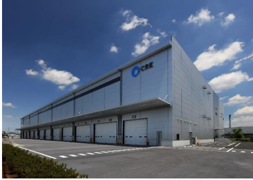
ロジスクエア川越Ⅱ 2019年6月竣工
