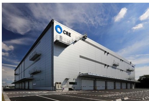
ロジスクエア春日部 2018 年 6 月竣工
